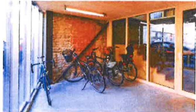
Local vélo avec bonne qualité d'éclairage naturel DLW architectes, Nantes.
