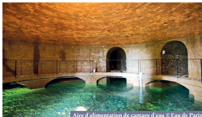
Aire d'alimentation de captage d'eau © Eau de Paris
