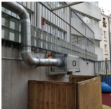
Cours de la crèche Verdun (haut) Sortie de la VMI®- Crèche Verdun (bas) Source : Urban Lab
