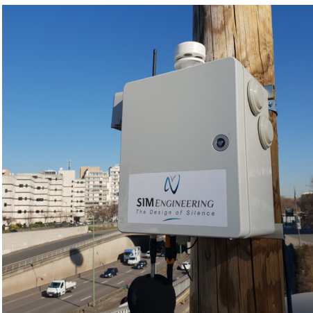
La station multiphysique SIMEngineering sur site Porte Maillot. Source : SIMEngineering
