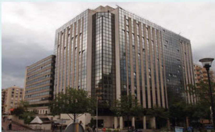
Transformation de 22 000 m 2 de bureaux en logements – Sky, Courbevoie (92400)
