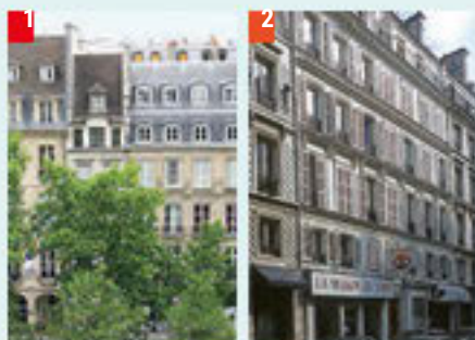
Immeubles de l'Ancien régime Cheminées : bois
