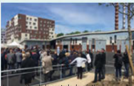
Inauguration de la centrale de géothermie de Villejuif (94)
