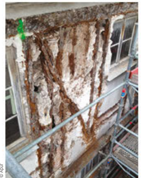
Exemples de « désordres » générés sur des bâtiments de faubourgs par l'application du triptyque « polystyrène – double vitrage – VMC » rue du temple (75004) / rue Saint-Denis (75002)
