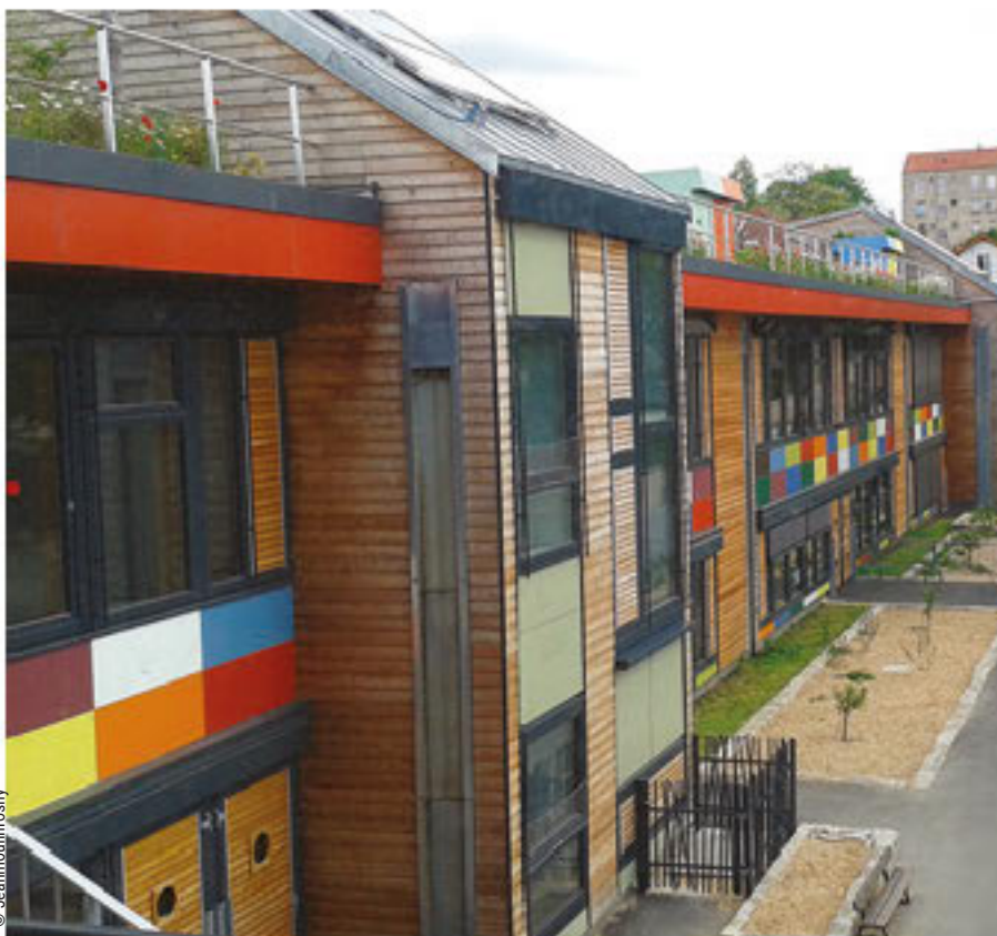
Ecole maternelle des Boutours à Rosny-sous-Bois, un exemple de bâtiment passif intégrant les principes bioclimatiques, le recours à des matériaux biosourcés locaux (bois-paille), et de l'agriculture urbaine en terrasse. Architectes de la Ville de Rosny sous Bois (Emmanuel Pezrès, directeur de projet).
