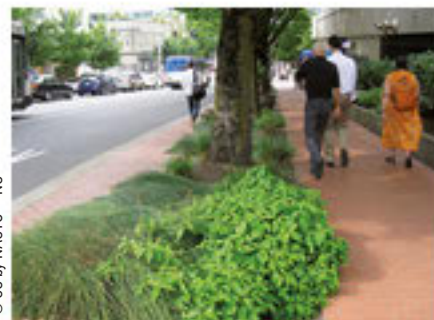
Tranchée continue recueillant les eaux pluviales, Portland
