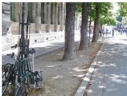
Tranchée continue avec bordure, Paris 4 e
