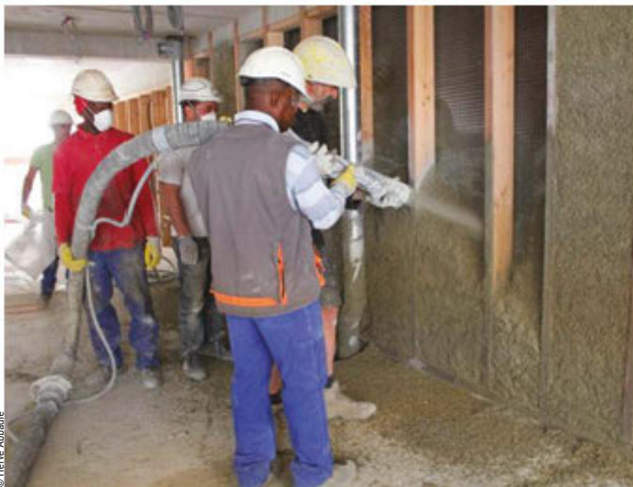
Projection de béton de chanvre dans un coffrage bois, immeuble neuf rue Bourgon, 13 e arrondissement
