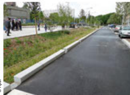
Espace planté recueillant les eaux de chaussée, les 4 000, La Courneuve
