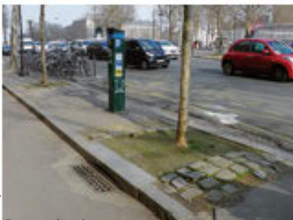
Espace planté non connecté, boulevard Bourdon, Paris 4 e
