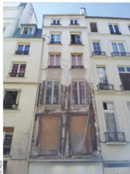
Exemples de « désordres » générés sur des bâtiments de faubourgs par l'application du triptyque « polystyrène – double vitrage – VMC » rue du temple (75004) / rue Saint-Denis (75002)
