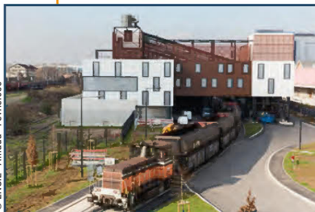
Centrale biomasse de Saint-Ouen avec acheminement des granulés de bois par fer
