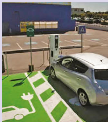
IKEA a installé des bornes électriques de recharge rapide pour véhicules électriques
