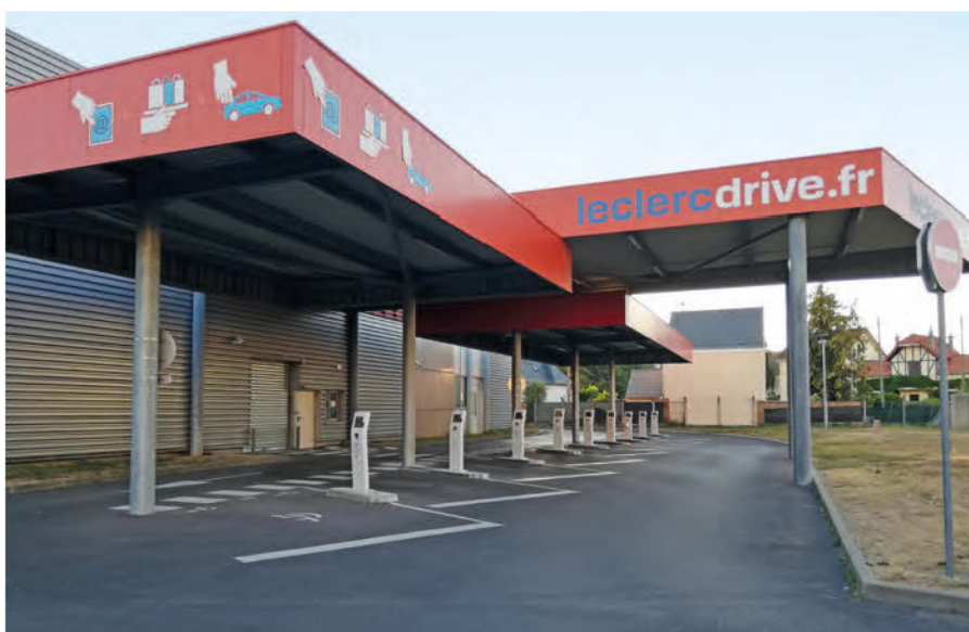
Le Leclerc drive de Palaiseau (91) est seul sur sa parcelle, il dispose de ses propres stocks
