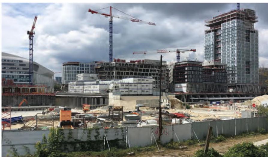
Vue sur le chantier du projet immobilier « L'Archipel », futur siège mondial de Vinci, à Nanterre La Folie
