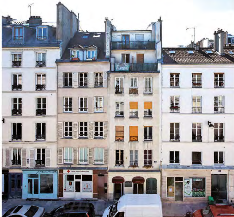
Front bâti rue Caffarelli - séquence façades depuis la Mairie du 3 ème
