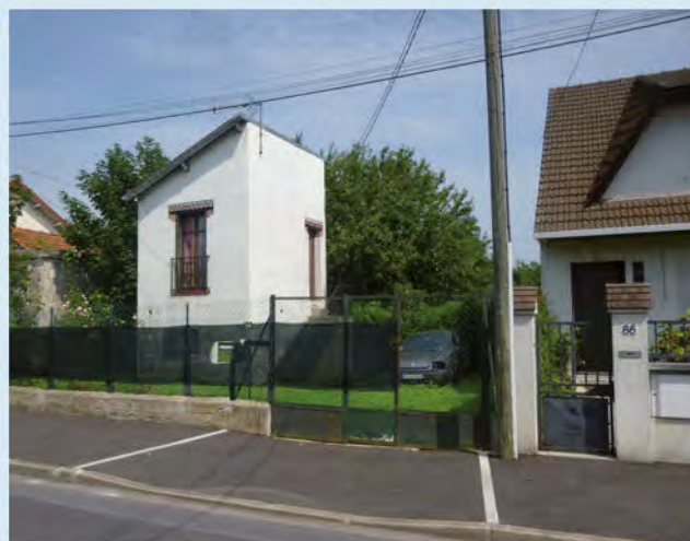
Pavillon à Sevrans
