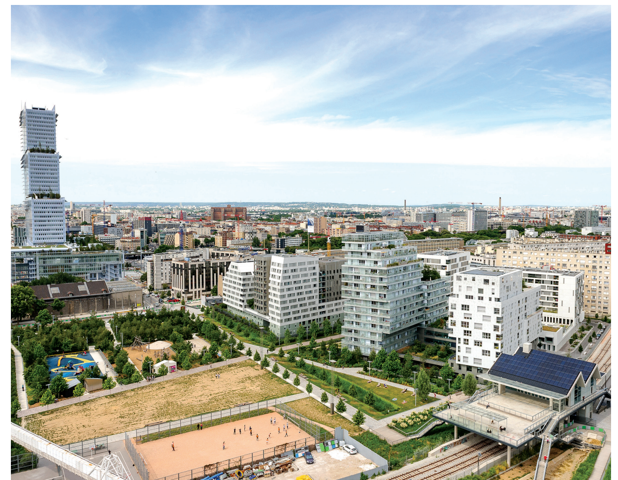
La ZAC Clichy-Batignolles est un projet ambitieux d'éco-quartier, dont l'un des enjeux est la formation d'un tissu urbain dense dans un environnement contraint, et la création de continuités urbaines entre des quartiers longtemps séparés par le faisceau ferroviaire Saint-Lazare et le boulevard périphérique.
