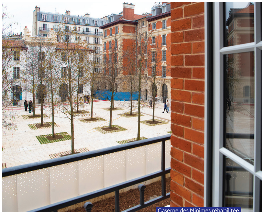
Caserne des Minimes réhabilitée
