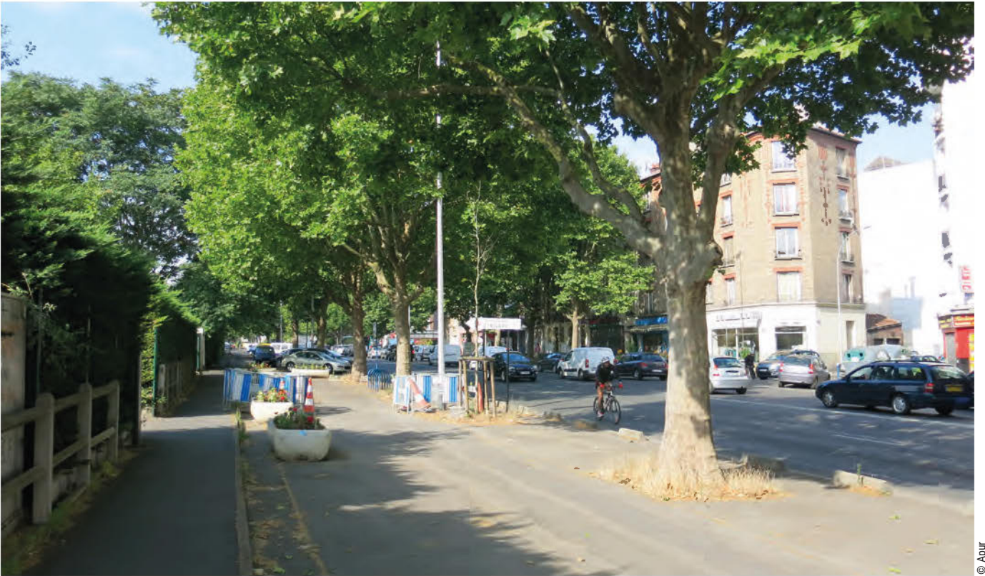
L'ex-RN2, d'Aubervilliers au Bourget, un axe central de l'aménagement cyclable de la Seine-Saint-Denis
