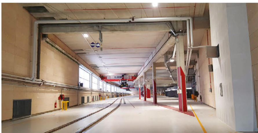
Site de Chapelle International doté d'une connexion fer-route (niveau 2), Paris 18 e
