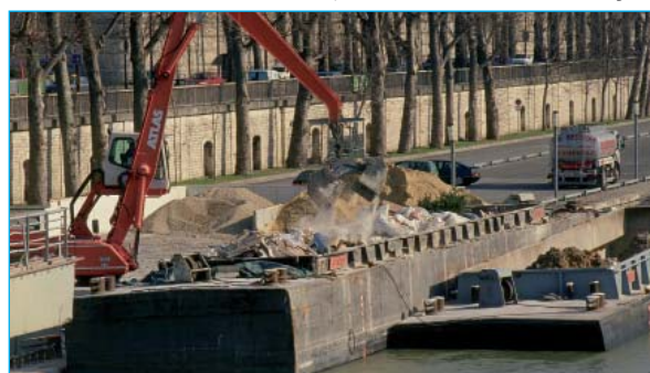
Transports par péniche de déchets industriels issus de démolitions d'immeubles, Quai de seine à Paris Bercy
