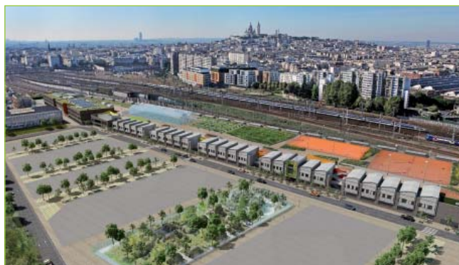
Hôtel logistique de Chapelle International connecté au fer, au périphérique et à l'A1, projet de la Sogaris à Paris
