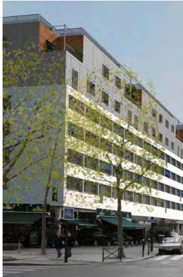
Surélévation de logements Cité Glacière, 13e, Ehw Architecture, 2018
