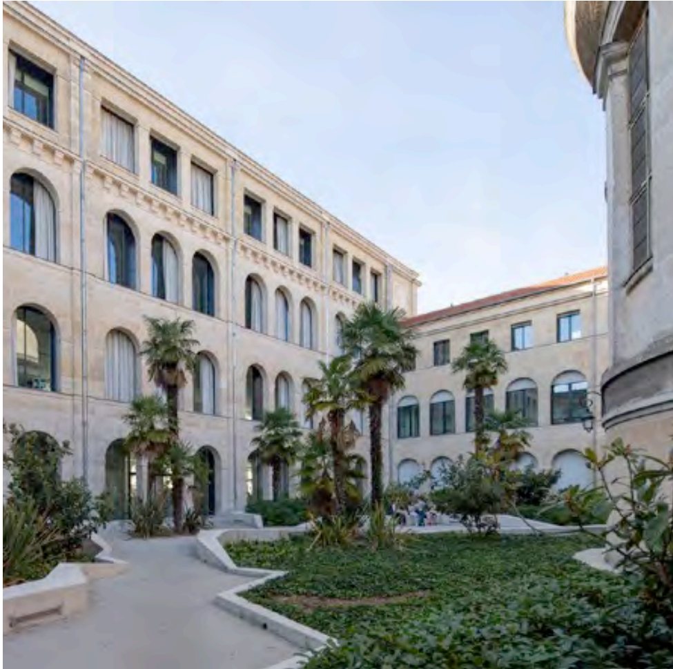
Transformation de l'Hôpital Saint-Lazare en médiathèque, 10e, Bigoni Mortemard architectes, 2015
