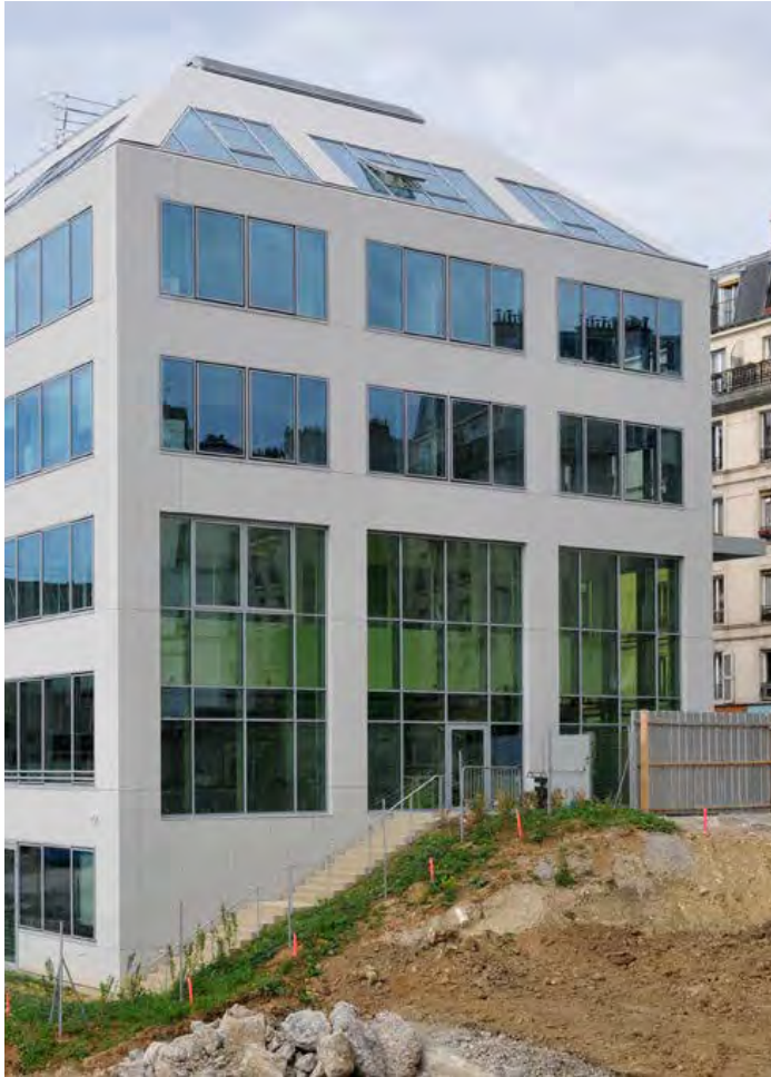
Hôtel industriel, ZAC Pajol, 18e, LIN architecte, 2012
