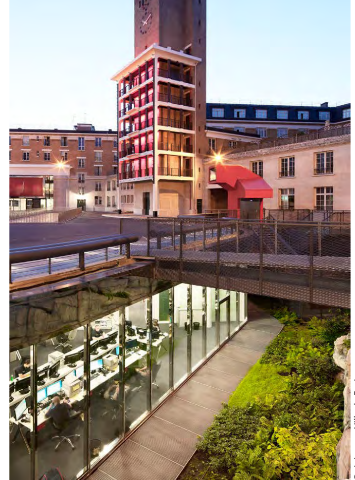
Réhabilitation de la caserne Champerret, 17e, Ropa Architectes, 2011
