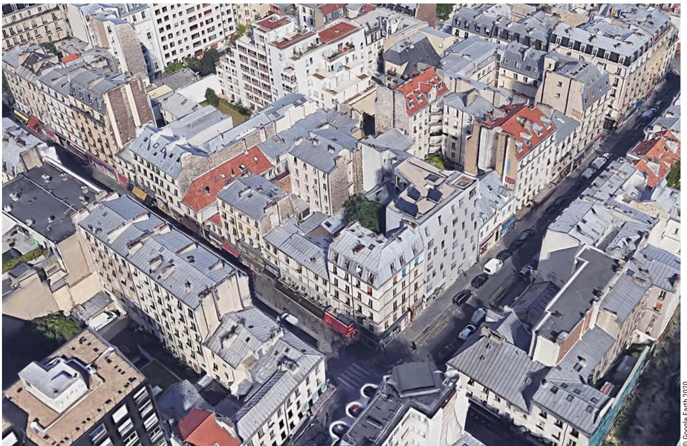
Vue aérienne 179 rue Saint-Maur
