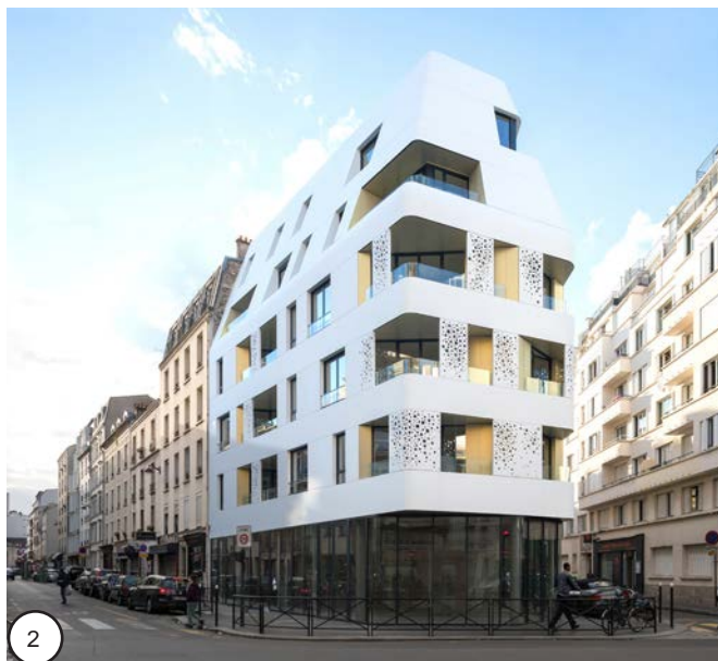
© Nakache & Orihuela Architectes (NOA), MOA Elogie Siemp, Photographie : Pierre l'Excellent
