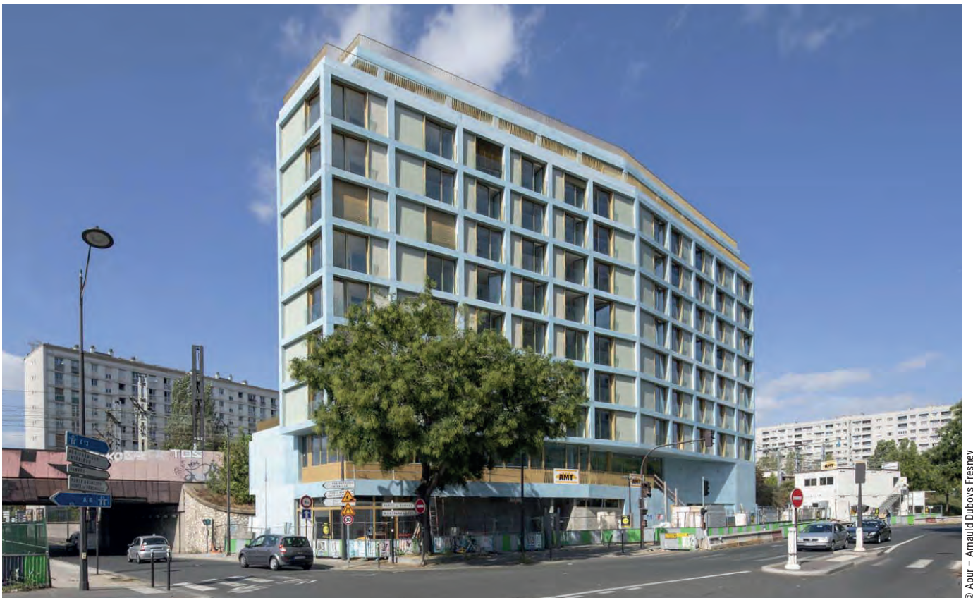
Résidence sociale de jeunes actifs de 87 logements, rue Julia Bartet (14 e ). Architecte : Charles-Henri Tachon.
