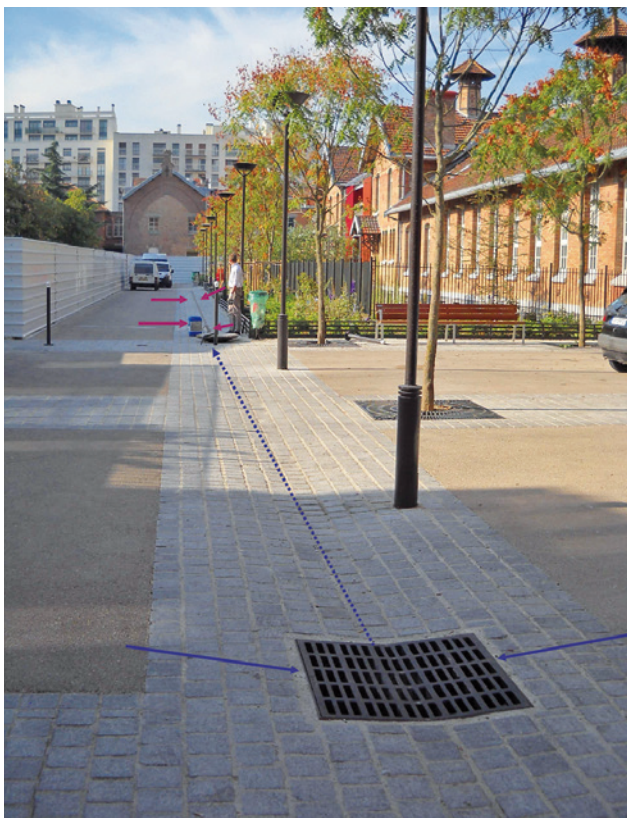
Tranchée drainante sèche avec caniveau en béton poreux – ZAC Boucicaut, Paris 15 e
