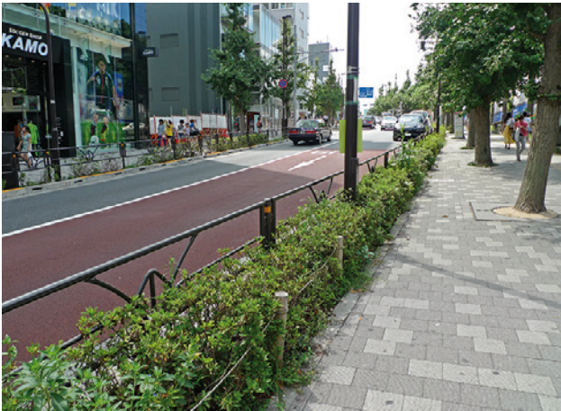
Exemple d'enrobé drainant au Japon
