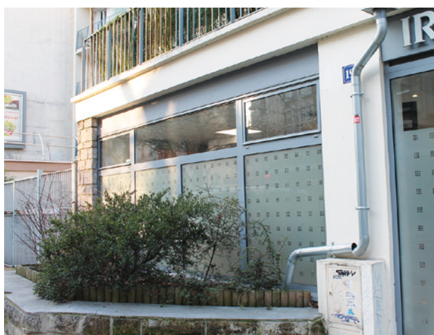
Exemple d'une descente EP qui pourrait facilement être déviée vers une jardinière de pied d'immeuble, rue Geoffroy Saint-Hilaire, Paris 5 e
