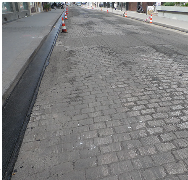
Réfection de la rue de Bercy, Paris 12 e Découverte provisoire du pavé existant
