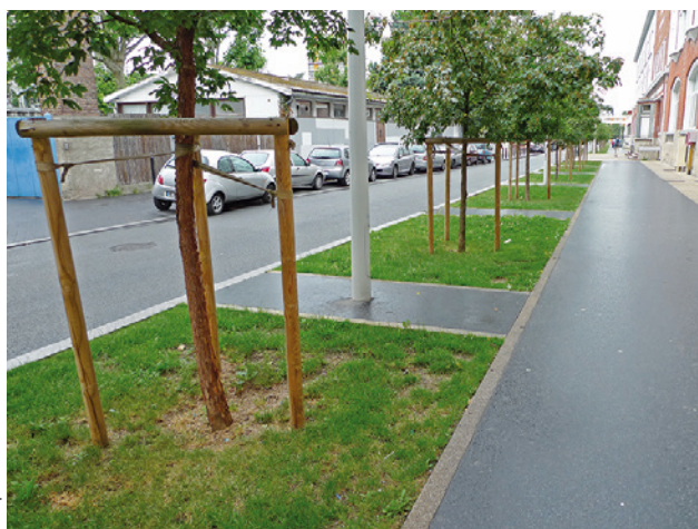
Tranchée continue d'arbres d'alignement, avenue de la République, La Courneuve, 93
