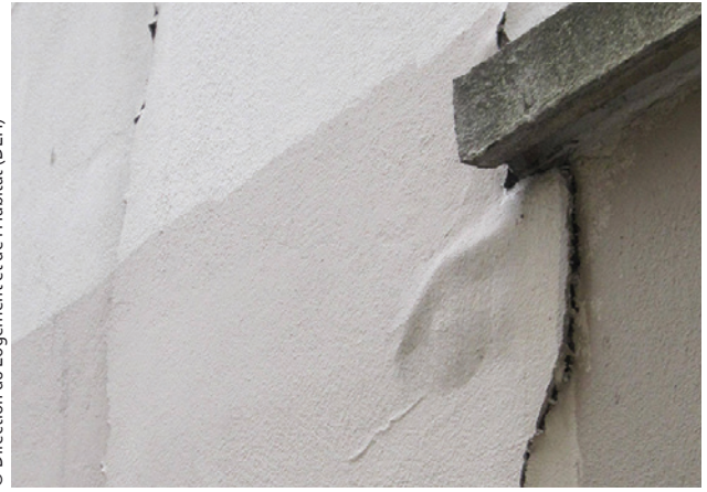
Décollement de l'enduit dû à une fuite d'eau émanant d'une pièce humide
