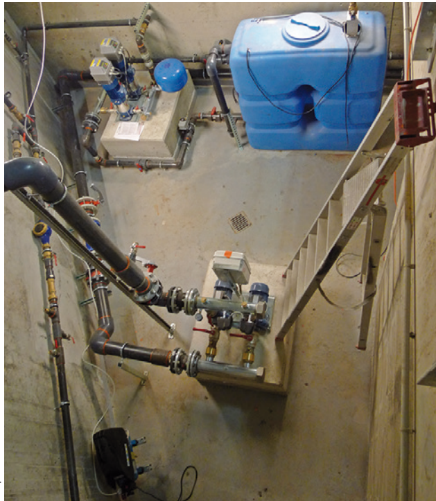
Système de récupération des eaux pluviales pour l'alimentation des sanitaires - Philharmonie de Paris, Paris 19 e
