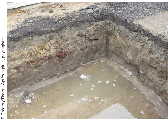
Fosse de plantation mal décompactée, qui peut poser des problèmes d'hydromorphie
