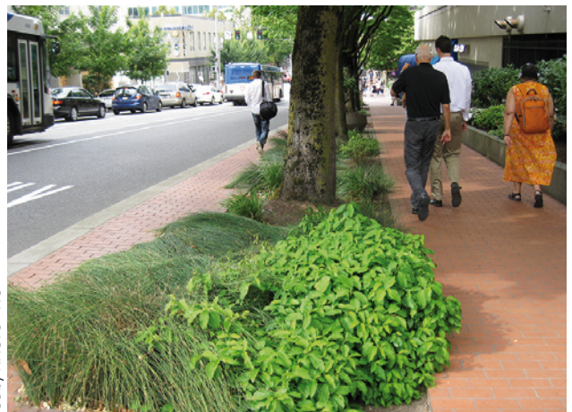
Tranchée continue recueillant les eaux pluviales, Portland
