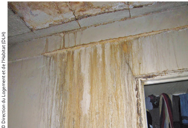
Fuite d'eau provenant de l'étage supérieur ainsi que de la salle d'eau
