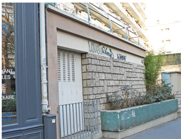
Exemple d'une descente EP qui pourrait facilement être déviée vers une jardinière de pied d'immeuble, rue Geoffroy Saint-Hilaire, Paris 5 e
