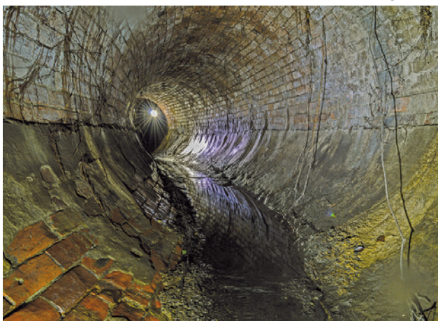
Développement de racines d'arbres dans les canalisations, États-Unis
