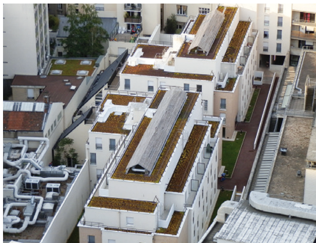
Toiture végétalisée au-dessus d'une résidence étudiante, Paris 13 e
