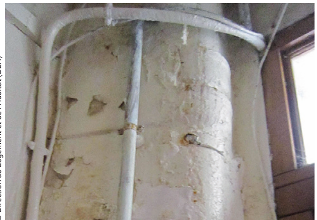
Porosité d'une vieille colonne en fonte d'eau usée
