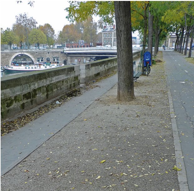
Expérimentation d'une résine type permeaway, boulevard Bourdon, Paris 4 e .
