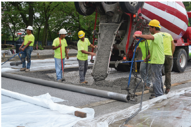
Pose de béton poreux dans l'Illinois
