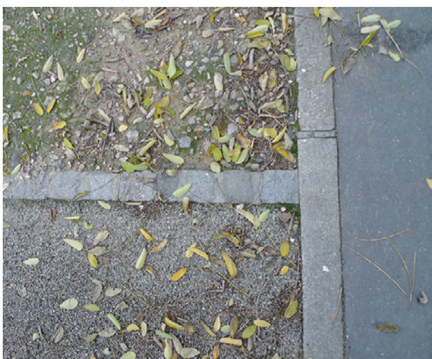
Détail de revêtement : en haut stabilisé, en bas permeaway, à droite asphalté, boulevard Bourdon, Paris 4 e
