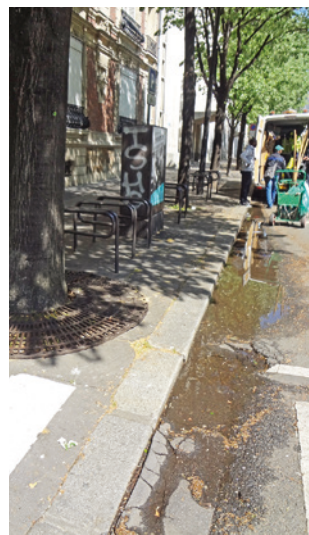
Racines de tilleul affleurantes sous le caniveau
