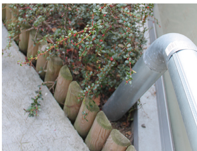
Exemple d'aménagement d'une jardinière en pied d'immeuble récupérant les EP, rue Geoffroy Saint-Hilaire, Paris 5 e
