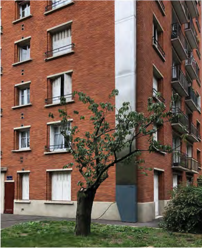
Déconnexion de gouttière et utilisation de l'eau de pluie (10°)
