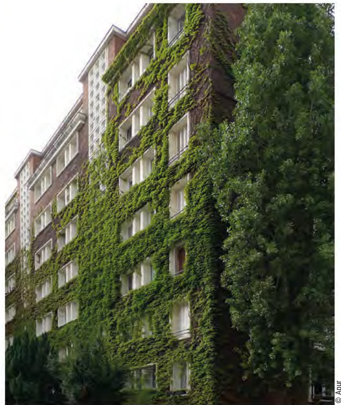
Façade d'immeuble végétalisée (13°)
