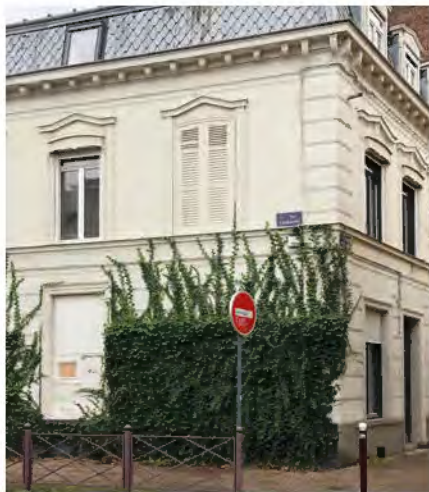
Opération « Verdissons nos murs » (Lille)
