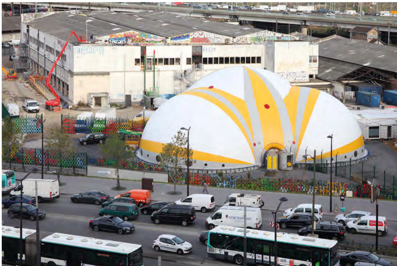
Centre de premier accueil, porte de la Chapelle à Paris (18 e ), novembre 2016 – mars 2018. Architecte : Julien Beller.
