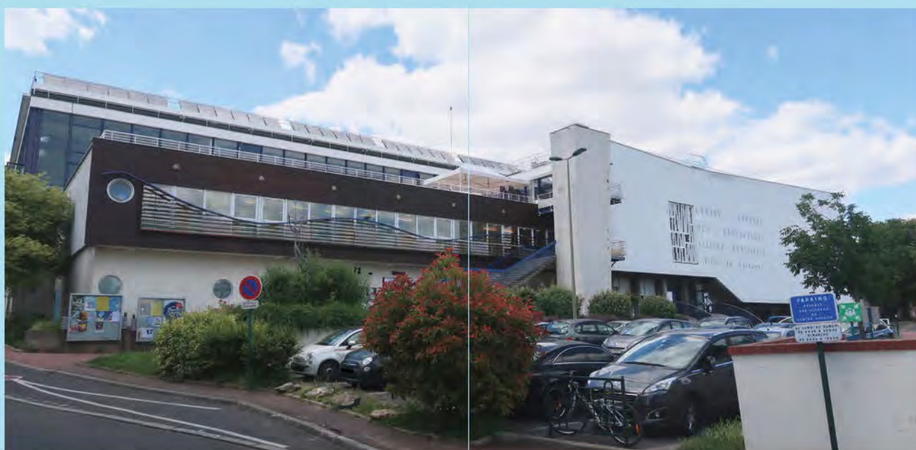
Centre sportif des Raguidelles à Suresnes.
