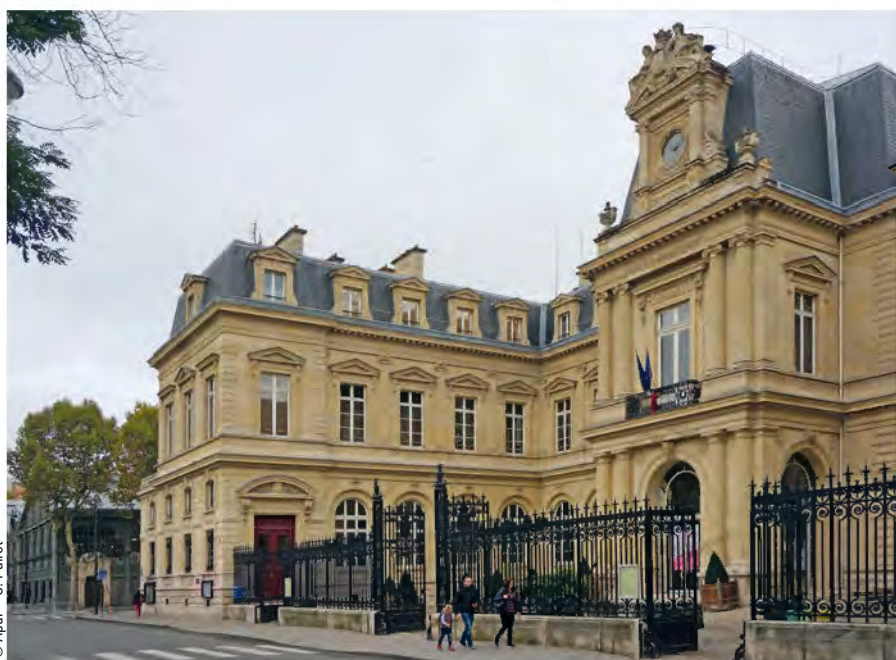
Mairie du 3 e , future Mairie de Paris Centre (1 er , 2 e , 3 e et 4 e arrondissements).
