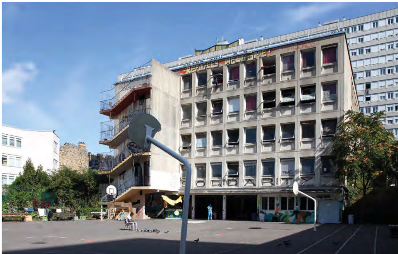
L'ancien lycée Jean Quarré à Paris (19 e ), utilisé en tant que centre d'hébergement d'urgence avant sa reconversion en médiathèque et maison des réfugiés.
